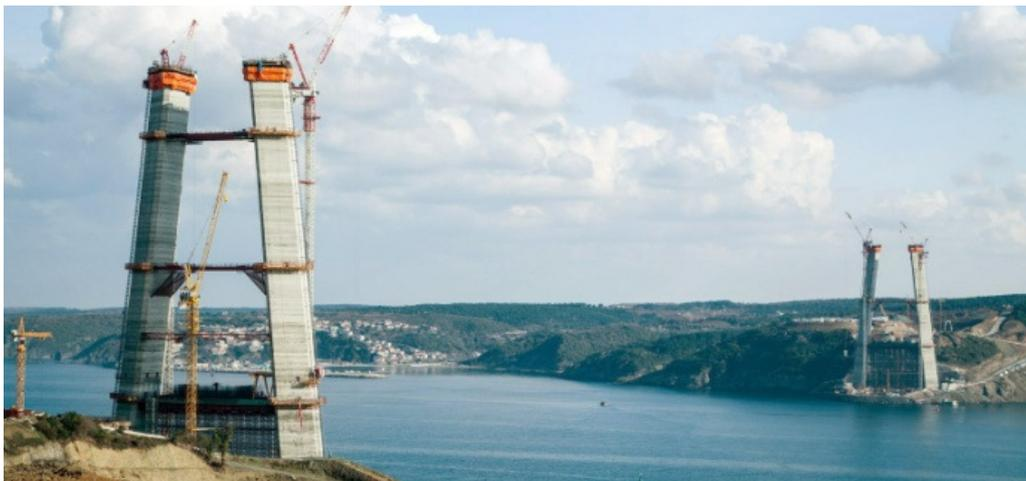
Figura 10 – Il terzo ponte sul Bosforo in costruzione, vista dal lato Europa. Si riconosce la presenza di 4 impianti slipform, uno per ciascuna torre
