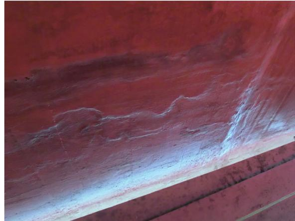
Figura 6 - Colature e rigonfiamenti dovute a calcestruzzo semifluido (al di sotto del bordo inferiore della slipform)
