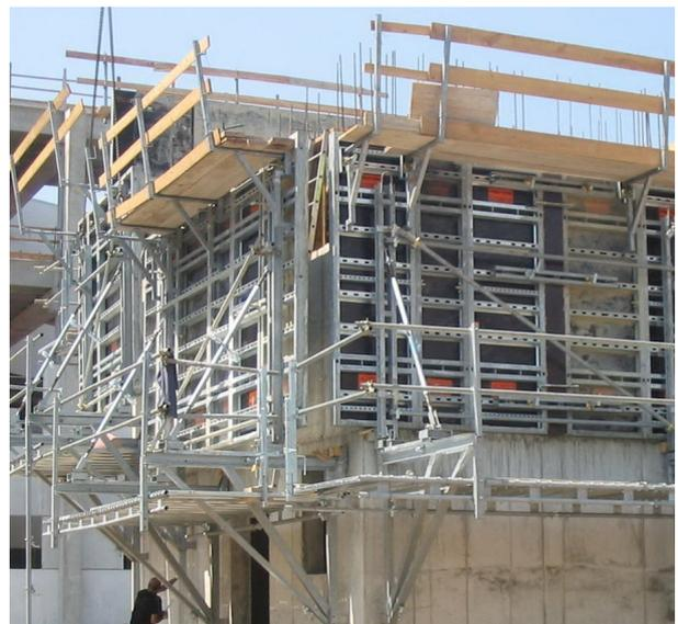
*Figura 1 - Sistema di costruzione a cassero rampante. I casseri sono fissati alle pareti e, dopo il getto, smontati e sollevati in una posizione più alta, quando il calcestruzzo presenta una resistenza sufficiente (foto da Internet)*
